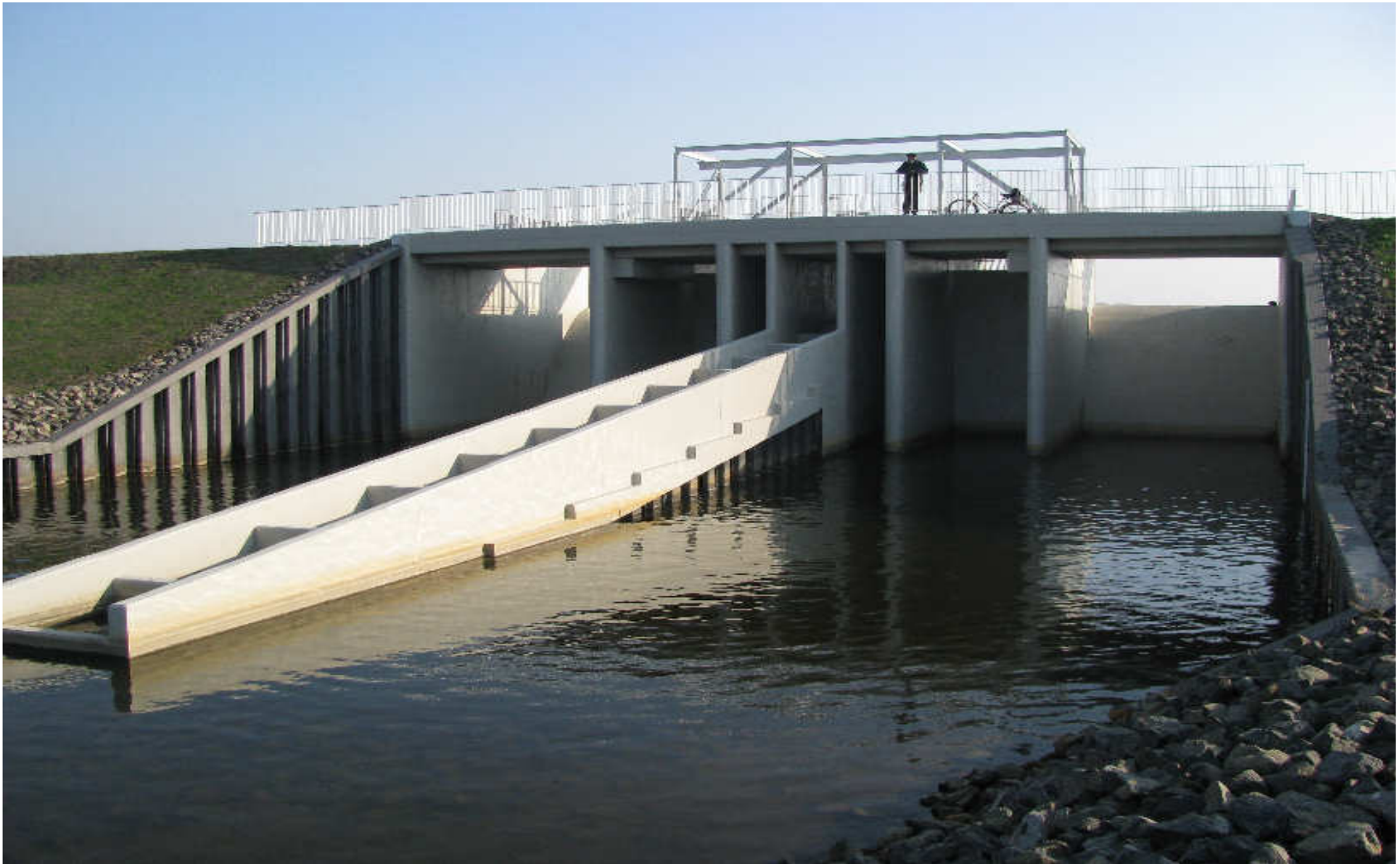
WIDOK NA BUDOWLĘ UPUSTOWĄ ZBIORNIKA OD DOLNEJ WODY
