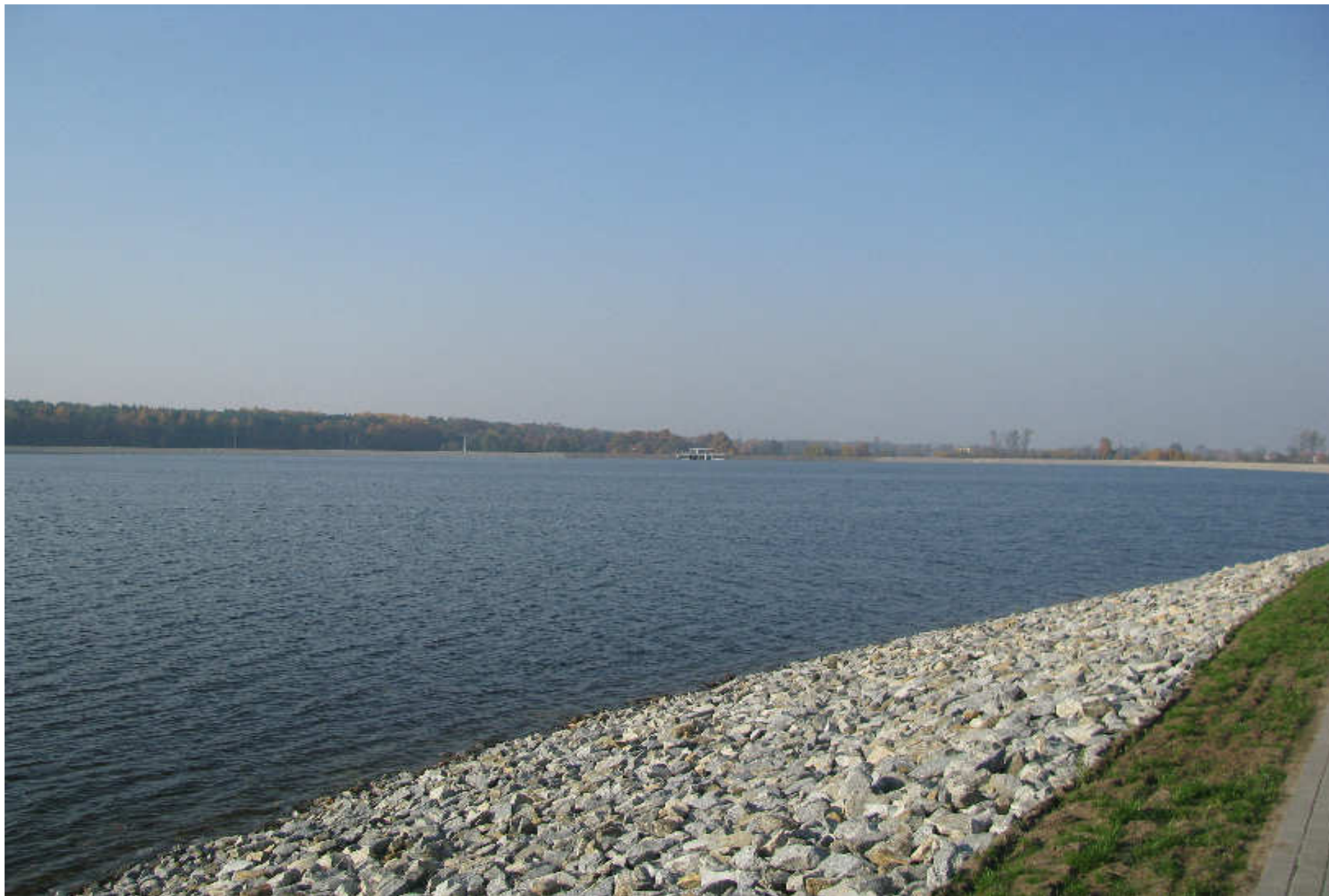
WIDOK NA ZBIORNIK W TRAKCIE OBCIĄŻANIA WODĄ
