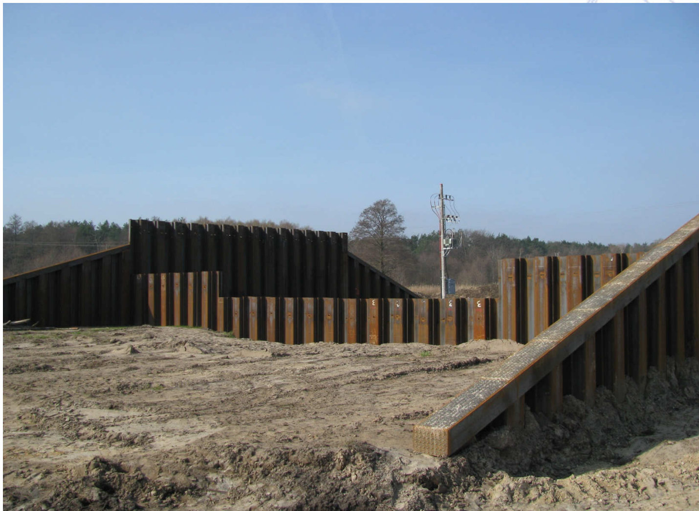
Zakończono wbijanie ścianki szczelnej
