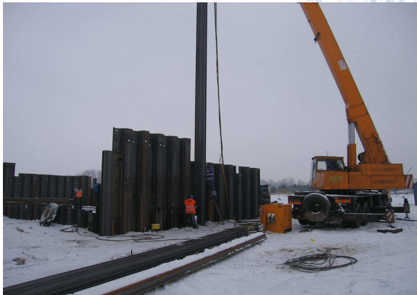
Wbijanie ścianki szczelnej pod budowlę spustową
