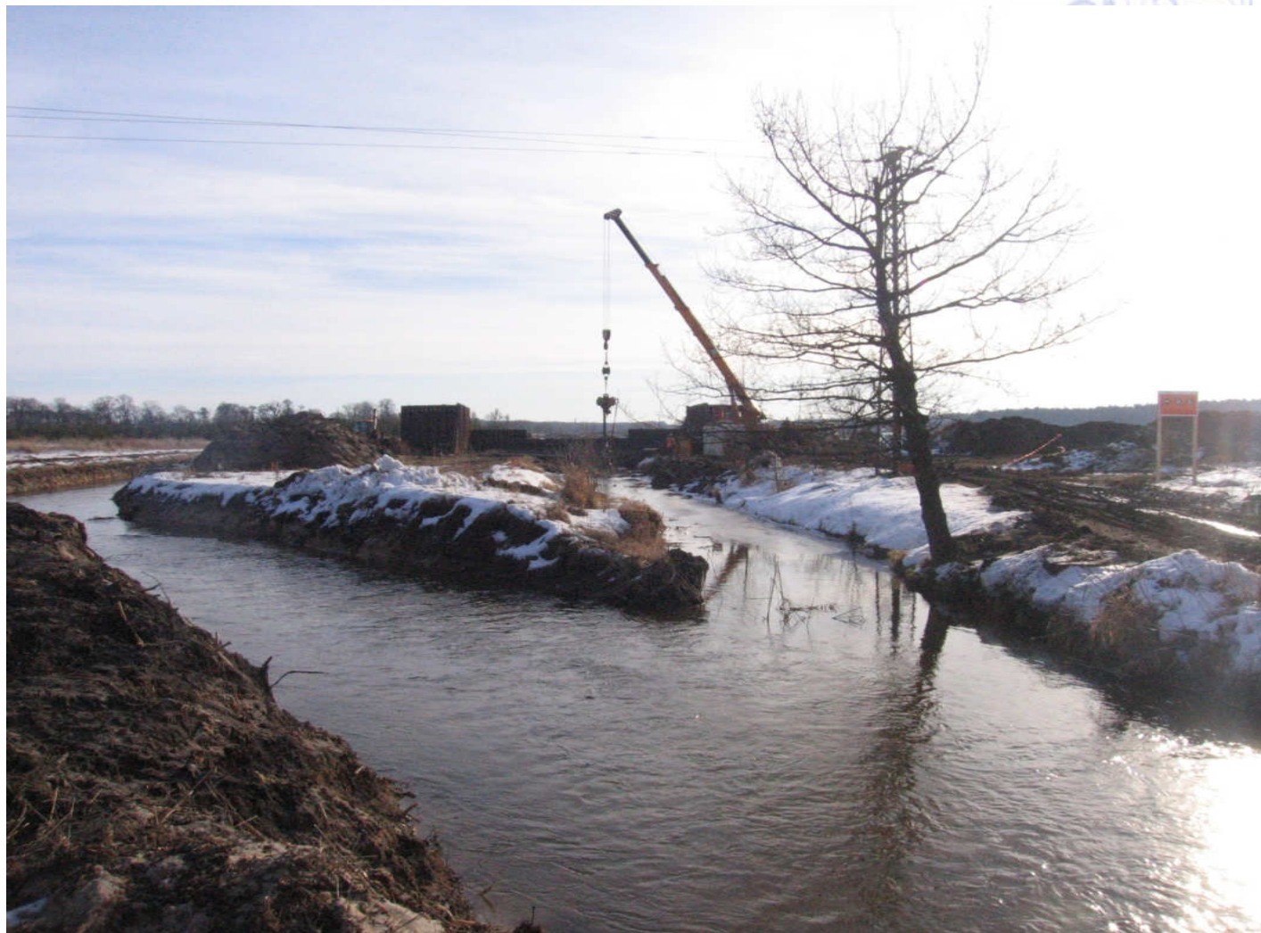
Przełożenie koryta rzeki Stobrawy na czas wykonywania budowy spustowej i zapory czołowej Zbiornika Kluczbork
