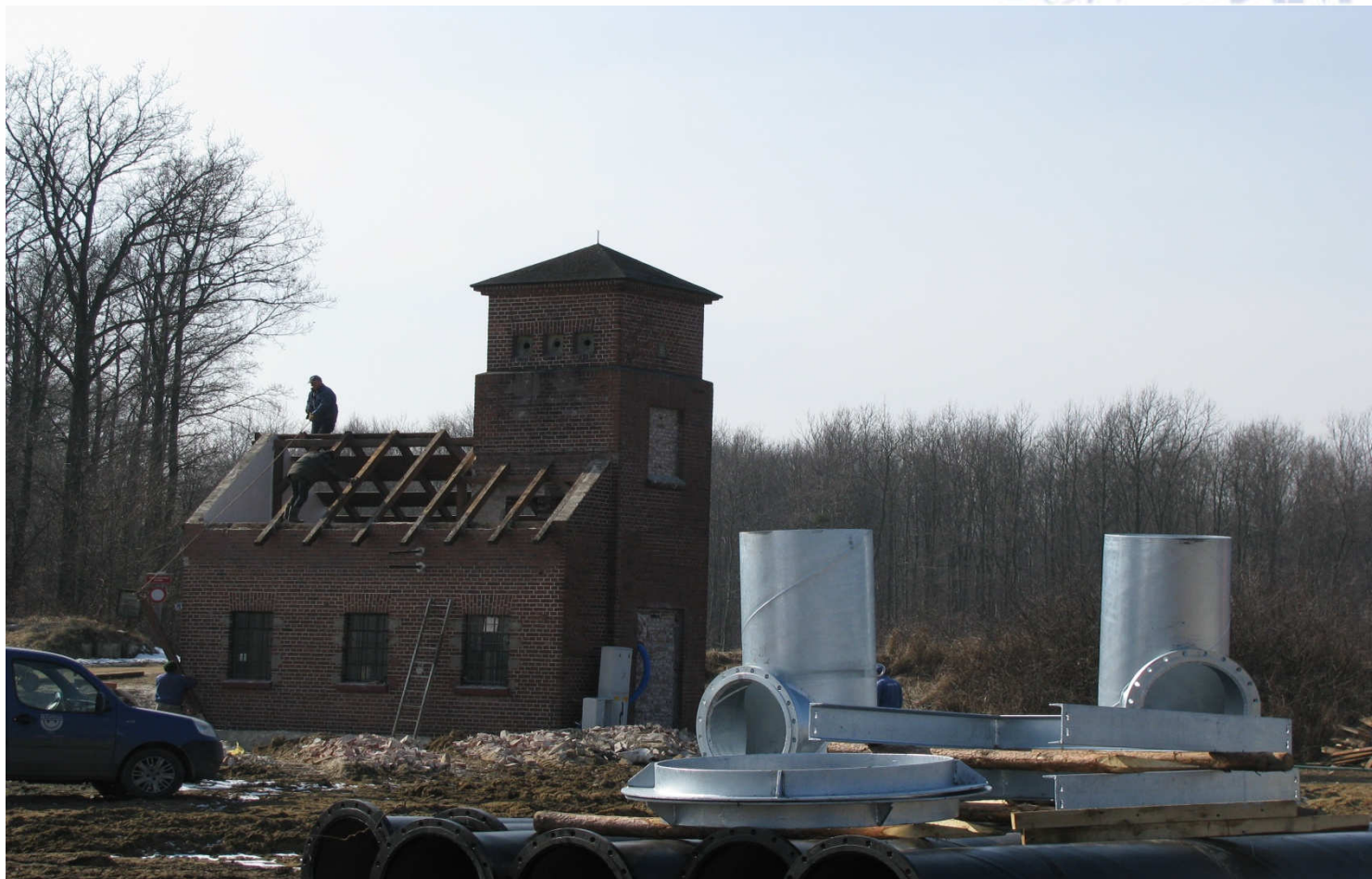
Rozbudowa i przebudowa pompowni Błota
